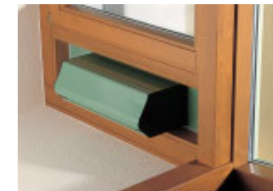
Lüftungsöffnungen am Boden sorgen bei der thermischen Lüftung für den Zustrom von kühler Luft.
