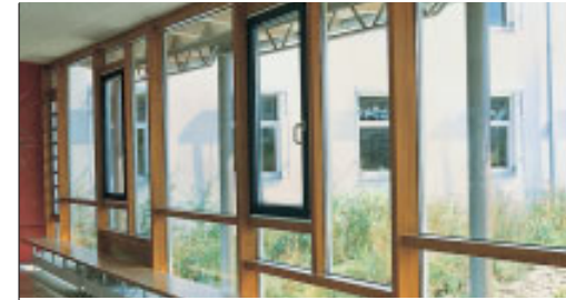
Gerade großzügige Glasverkleidungen erfordern perfekte technische Details.
